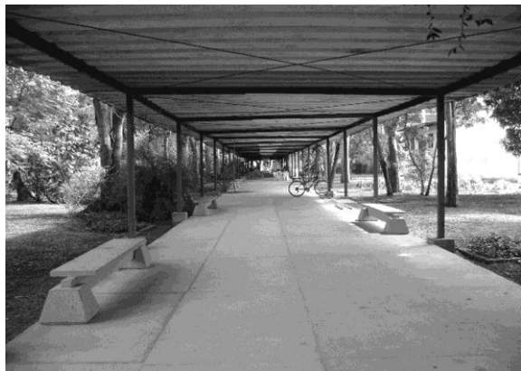
Obras de acessibilidade no IP
